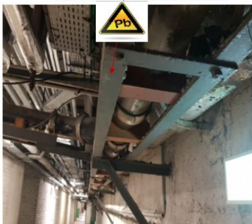
CHASSIS AVEC PEINTURE AU PLOMB
